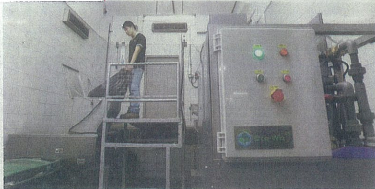
洲际酒店装置了两台厨余分解机器，可处理1.5公吨的厨余。员工正把厨余倒进机器中。
